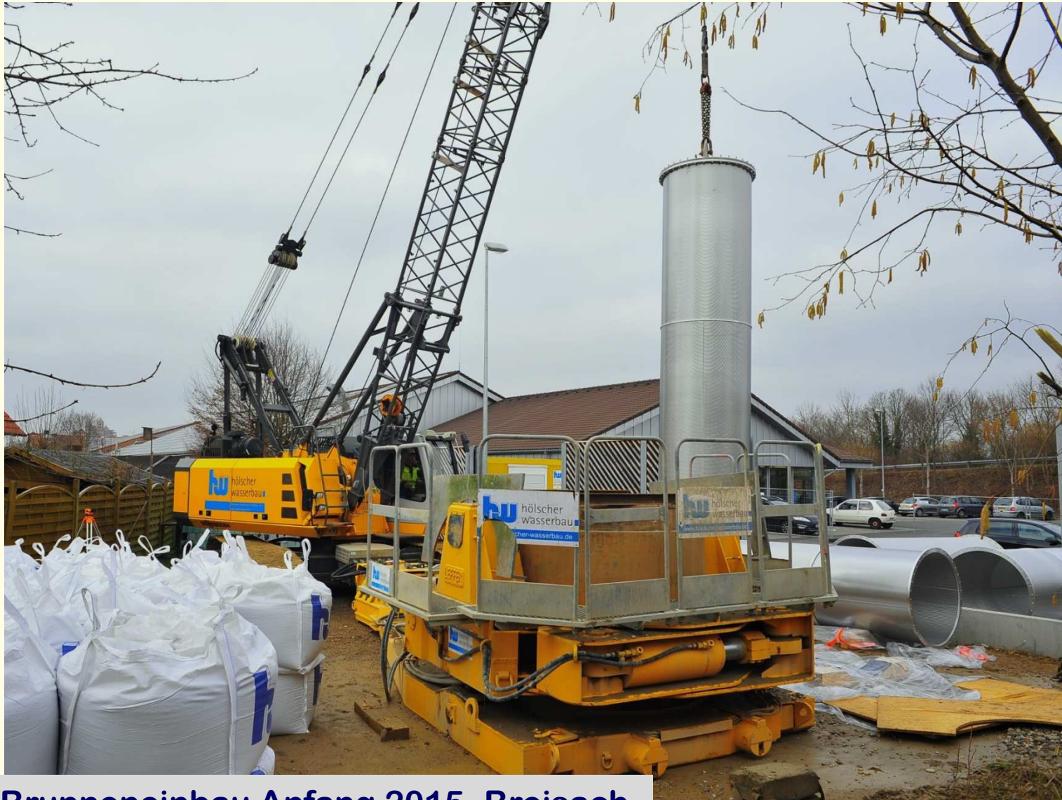
Brunneneinbau Anfang 2015, Breisach
